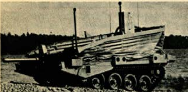
1. טנק "S" שוודי. למעלה — במצב רגיל, למטה — במצב כריעה ע"מ לאפשר הנמכת התותח- יריעת הצליחה וצינורות האוורור מורמים חלקית.
