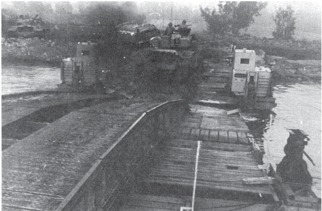
גשר דוברות ה"יונפלוט" נשבר וטנק גישור פתר את הבעיה
